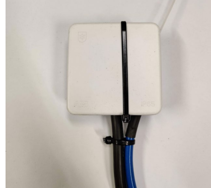
Kytkentärasian kansi kiinnitettynä ja varmistettuna nippusiteellä.
