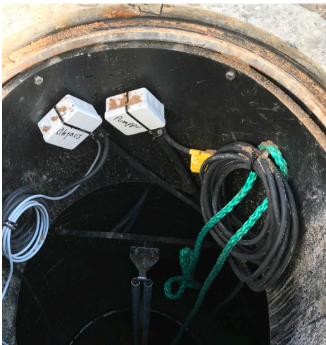
Pumpun oikeaoppinen kaapeleiden kiinnitys teleskooppiin.
