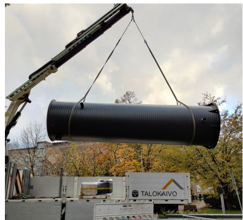
PEH-pumppaamon nostotilanne nostoliinoja käyttäen.
