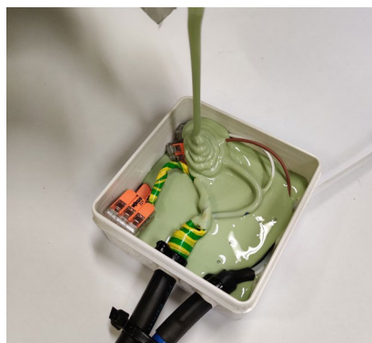
Sekoita hartsia hyvin ja kaada se rasiaan johtojen päälle.
