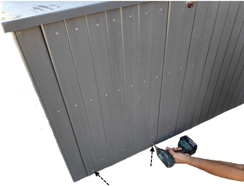
Kuva 3. Laitekaapin luukun irrottaminen
