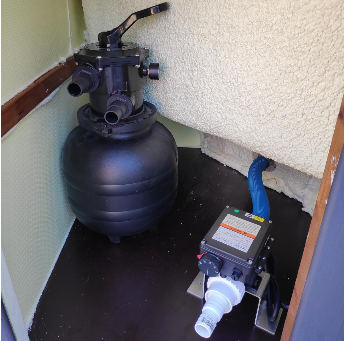
Kuva 8. Sähkölämmittimen asennus
