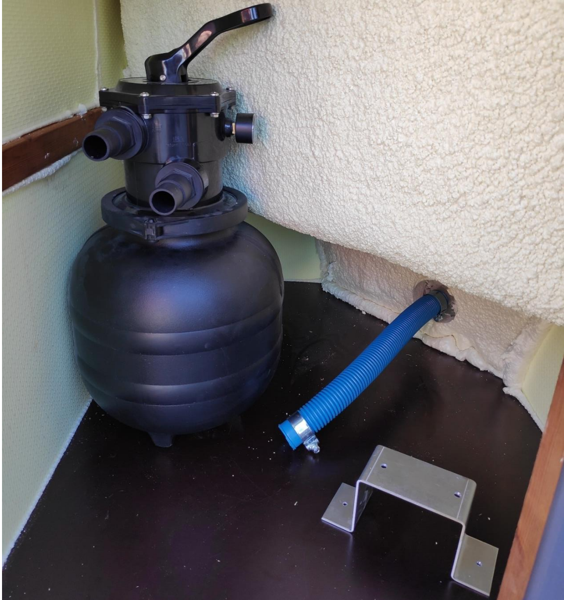
Kuva 7. Suodatusjärjestelmän asennus
